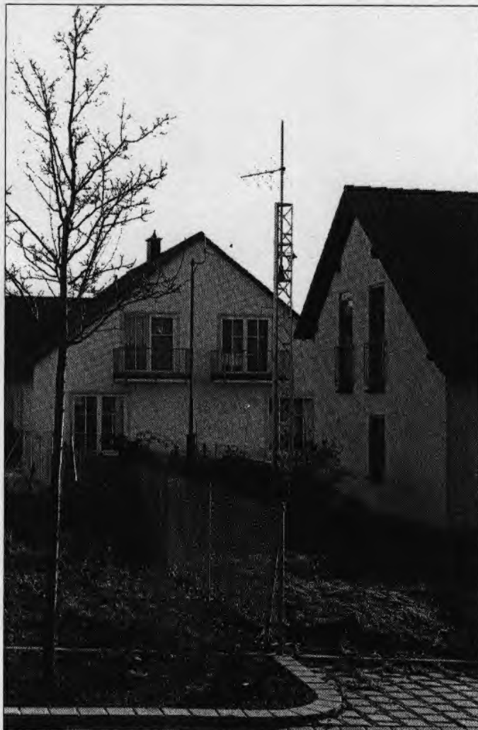
Blick auf die Antennenanlage aus der Sicht der klagenden Nachbarin B.
